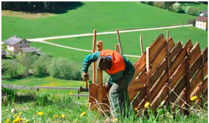
6–10 Izdelovanje rinka. Foto: Milka Olip, 4. 5. 2013. 11–16 Postavljanje plota z rinki v Selah. Foto: Milka Olip, 14. 5. 2013.
